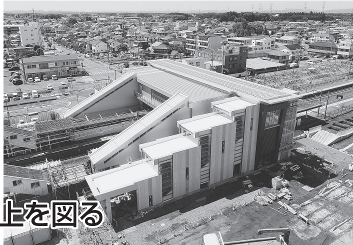
佐和駅東西自由通路 および新駅舎
