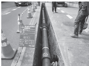
水道施設(管路)更新工事
