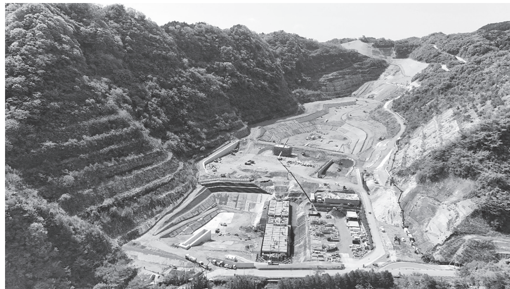
新処分場本体工事状況
