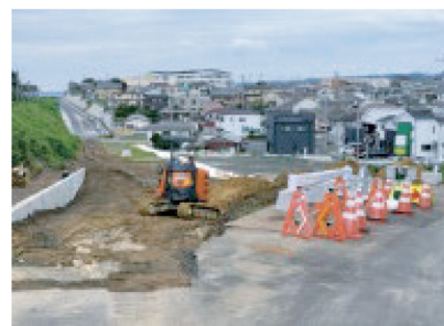
令和10年度の供用開始をめざす「市道3509号線改良工事」
