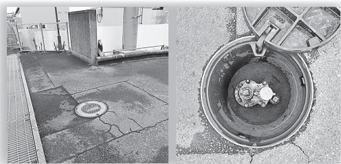
移設する消火栓（外観・内部）
